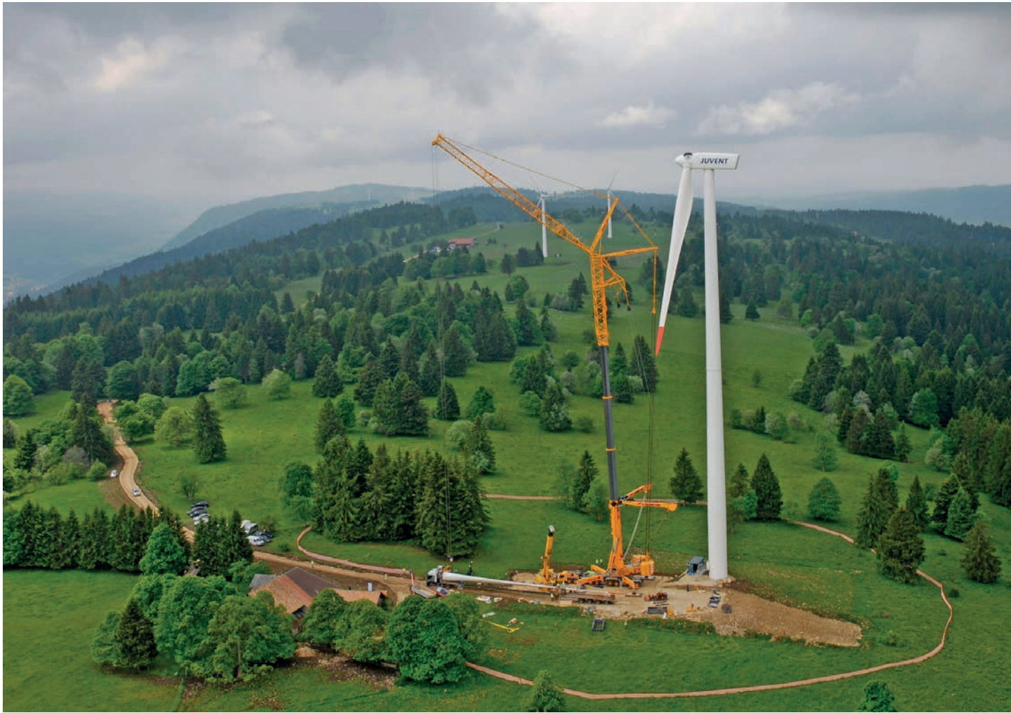
L'installation d'éoliennes, comme ici au Mont-Crosin, en 2016, nécessite d'importants travaux.
